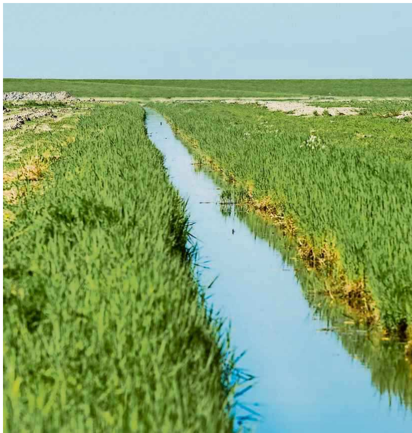
Als sloten worden gedempt, moeten de bestaande watergangen evenveel water kunnen bergen. Links: een oude sloot in Westhoek die binnenkort wordt gedempt. Rechts: een nieuwe, verbrede sloot. FOTO'S MARCEL VAN KAMMEN
